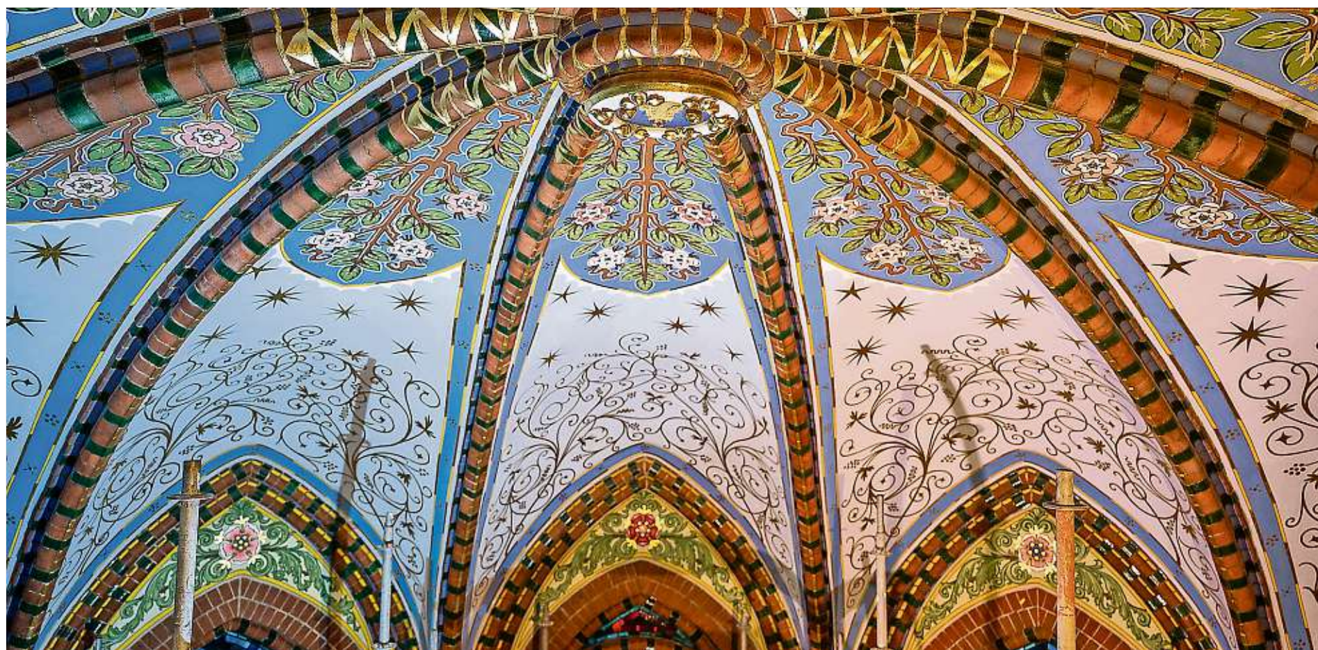
Das Gewölbe über dem Hochaltar leuchtet in allen Farben. Rund um den Schlussstein in der Mitte – der Paradiesgarten. Alles ist handgemalt, ohne Schablonen.
