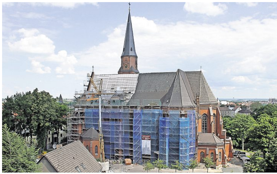
Juni 2013: Schon drei Monate nach dem Start der Bauarbeiten ist das Seitenschiff der Kirche eingerüstet und das Dach aufgerissen. Foto: Jens Trenkler
