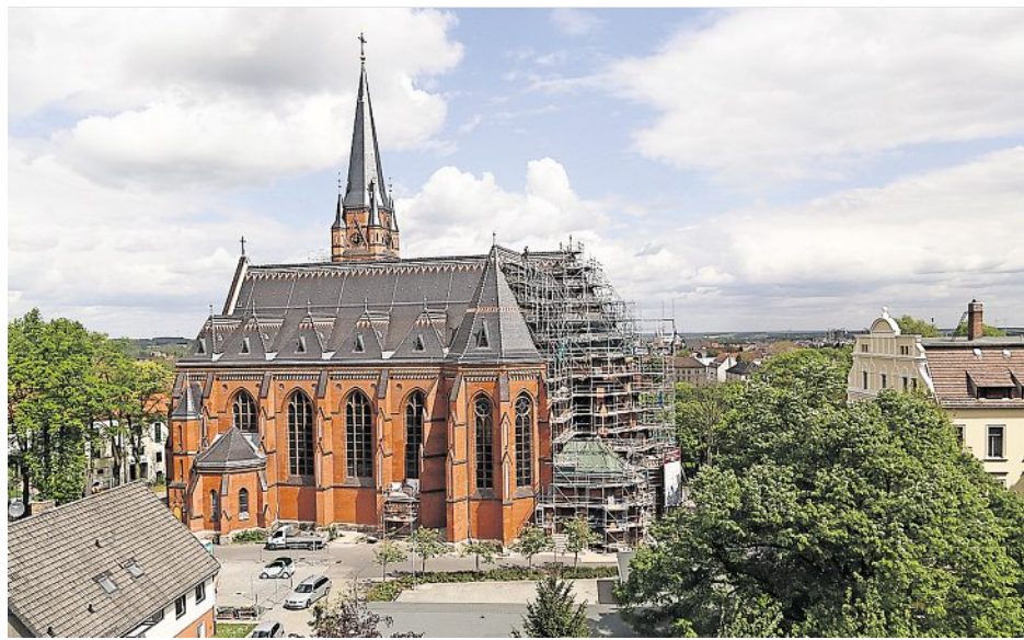
Mai 2015: Nur am Seitenflügel wird noch gearbeitet. Der Turm hat seine Seitenkröchen wieder. Das Dach ist nahezu komplett. Fotos (2): Nikolai Schmidt
