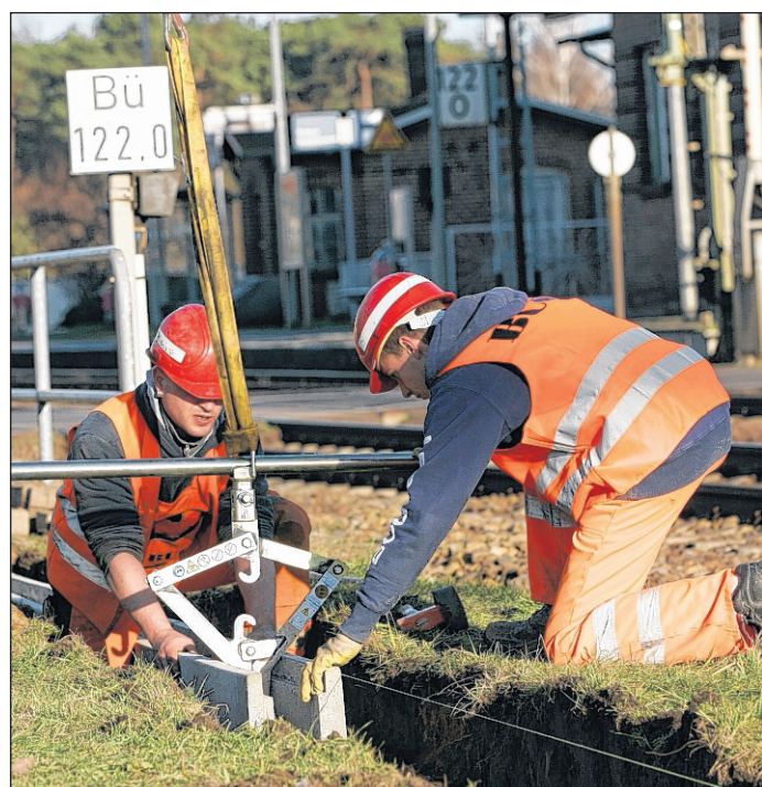
Stück für Stück: Zwei Mitarbeiter der BUG Verkehrsbau AG verlegen in Coschen einen Betonkabelkanal. Foto: MOZ/Gerrit Freitag
