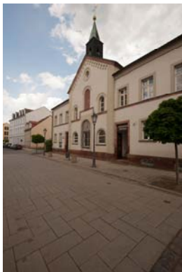
Die Kirche in Grimma. Sie wurde bereits zum zweiten Mal überflutet. Foto: Bonifatiuswerk
