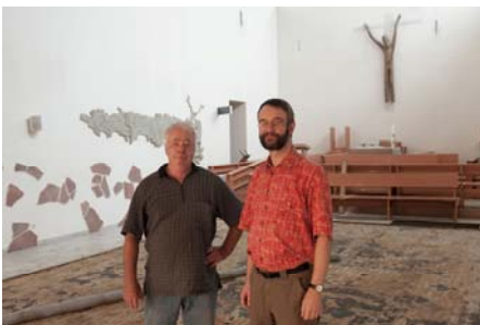
Pfarrer Gregor Hansel (re.) und Pfarrgemeindeglied Norbert Werner in der flutgeschädigten Kirche. Foto: Bonifatiuswerk
